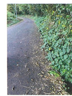
小学校下の道。大雨の時は草木で溝が塞がれて水が道のほうへ流れてくる。
