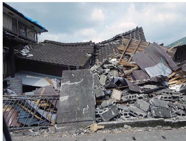
平成28年熊本地震（当時の益城町の様子）
