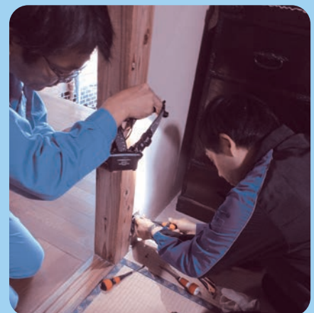
コンセント交換の様子
